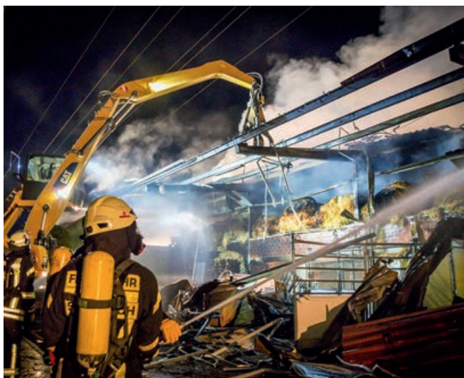
Die Ausräumarbeiten mit einem Schrottbagger.
